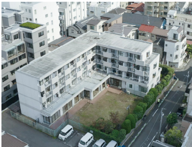
現在の寮舎の全景
